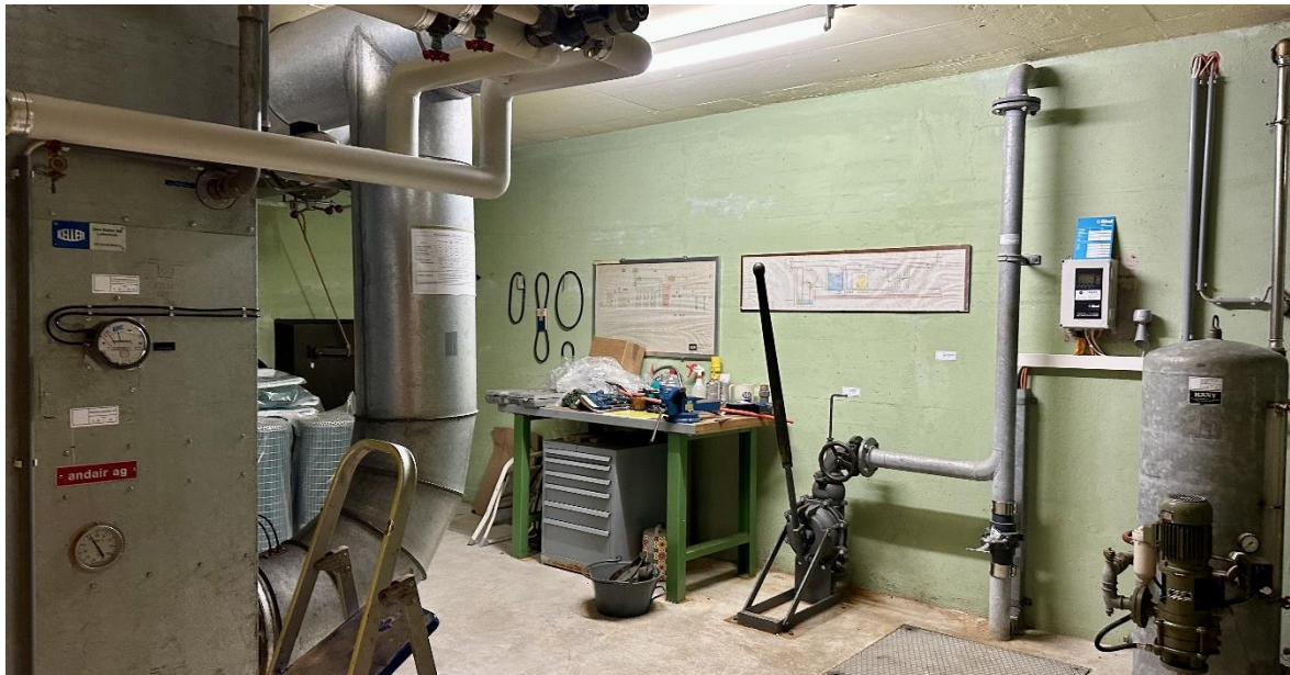
Zivilschutzanlage unterhalb der Neuwieshalle
